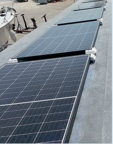
12 panneaux photovoltaïques 410 W - 4920 W BATTERIES lithium 1490 A
